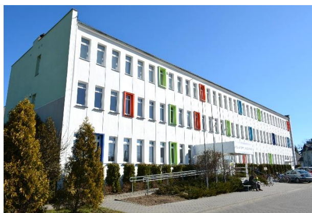
Siedziba PUP Chojnice po zakończeniu prac remontowych
