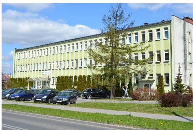
Siedziba PUP Chojnice przed remontem elewacji
